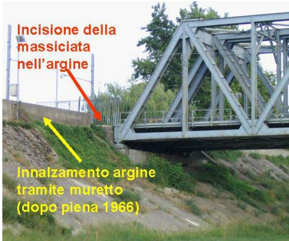
Figura 15: Il ponte ferroviario della linea Venezia-Trieste presso Latisana . Si nota come la struttura risulti incassata nell'argine, causando un'incisione nel muretto di protezione.
